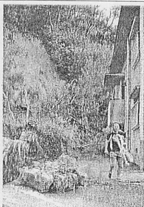
裏山が崩れ敷地内に土砂や岩が流れ込んだ教職員住宅 ＝2日午後、瀬戸内町古仁屋
